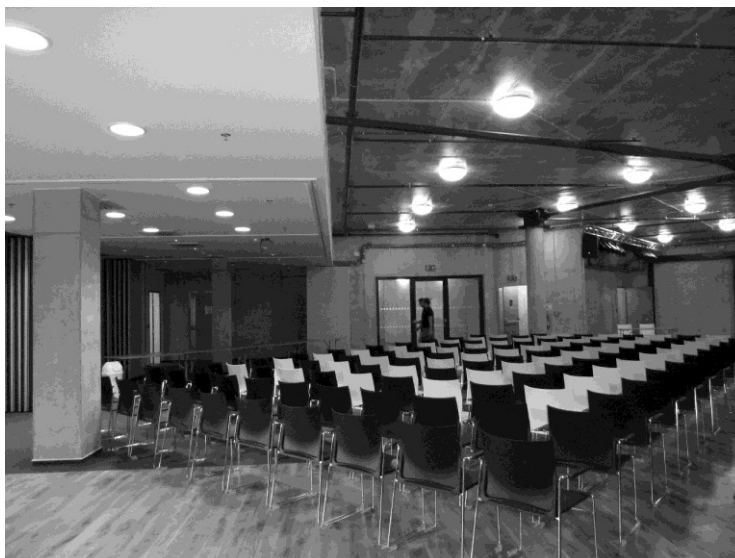
• Obr. 9. Osvětlení výukového sálu s jevištěm svítidly PLT 2x36W a DLT 2x17W
