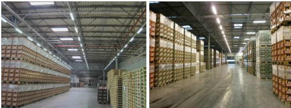
• Obrázek 6: Původní osvětlení a osvětlení po rekonstrukci
