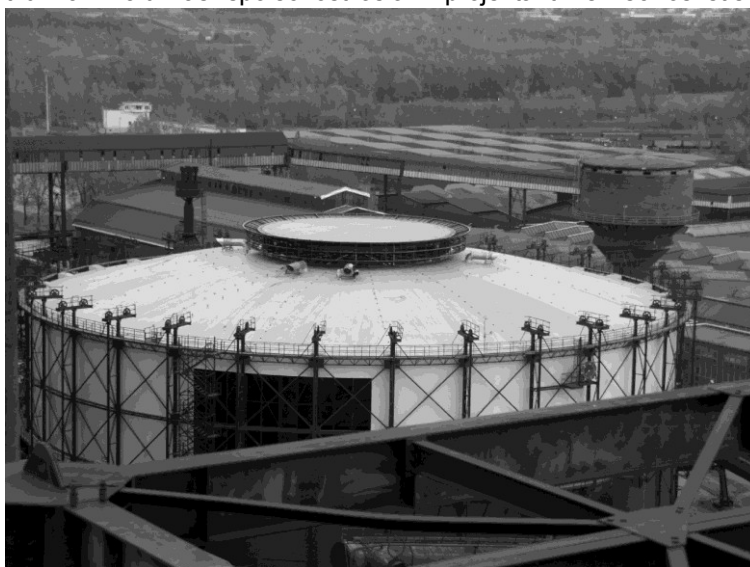
• Obr. 2. Zvon plynojemu po zvednutí
