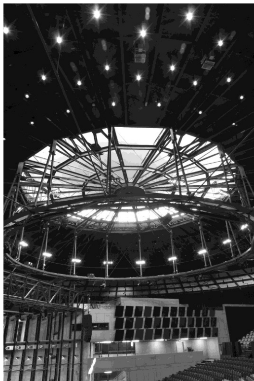
• Obr. 4. Pohled na centrální lustr o průměru 22m nepřímo nasvícený svítidly LINEA 80 a ochoz se svítidly KARDAN
