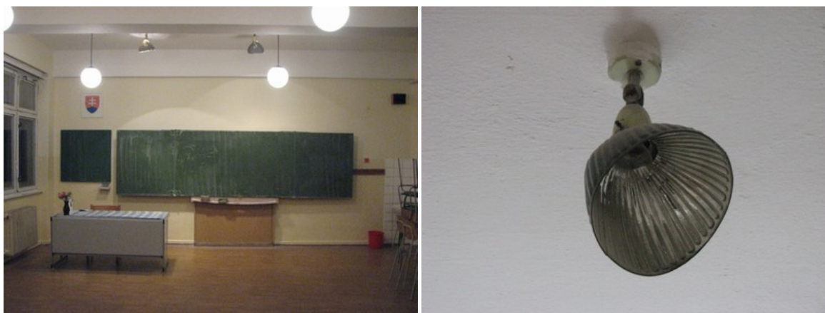
Obr. 2 Pôvodné osvetlenie tmavozelenej tabule žiarivkovým reflektorovým svietidlom
