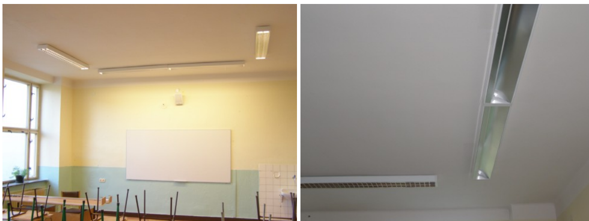
Obr. 3 Nové osvetlenie bielej tabule žiarivkovým svietidlom s asymetrickou optikou
